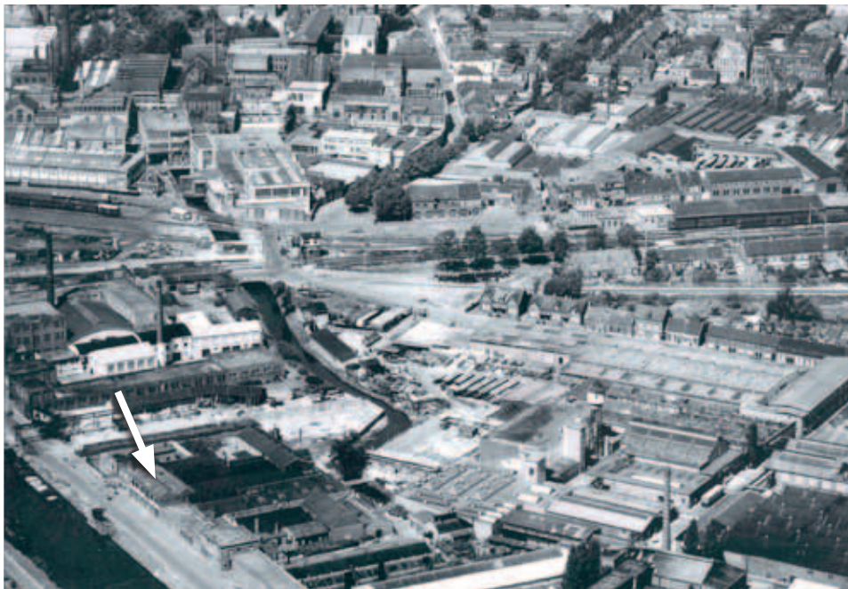
Luchtopname uit 1956 van het gebied rond 'de Oliemeulen' met daarop vooral de fabrieken van de HTM. Linksonder is een stukje van de Zuid-Willemsvaart te zien en bij de pijl de voormalige fabriek van Zwijzen. Het pand lag ingeklemd tussen het kanaal en een lus van de OudeAa. (Afbeelding uit: Helmond van boven bekeken, 1923-1980)
